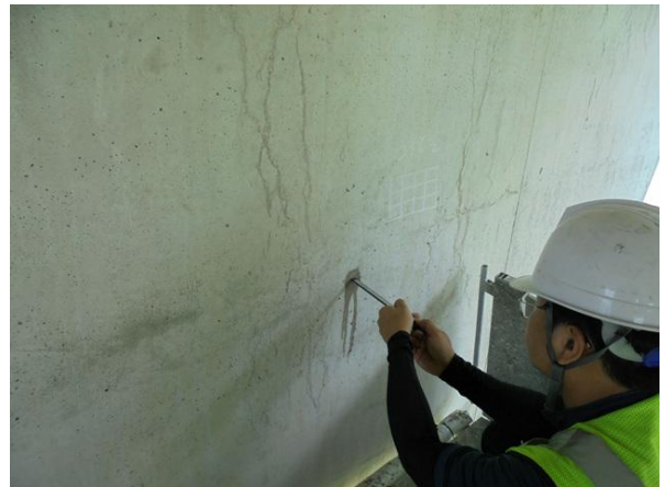
탄산화 깊이 측정
